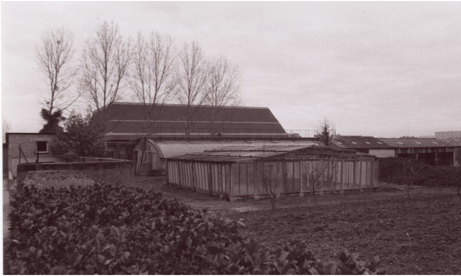
Les serres situées à l'arrière de la buanderie Coll. part.
