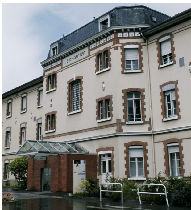
Le pavillon Le Chartier dédié à l'accueil du service de pédiatrie vers 2000. Cliché CHU. D. R.
